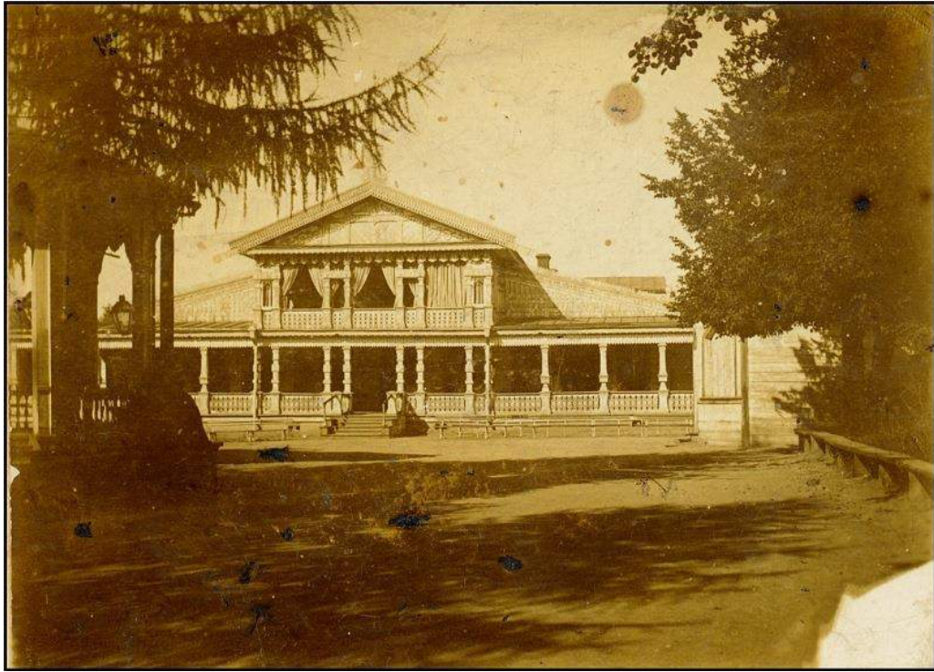
Рисунок 10. Городской сад, 1890-е – 1902 г. Фонды Рязанского историко-архитектурного музея-заповедника. Сейчас – Нижний городской сад (Городской парк..., 2021).
